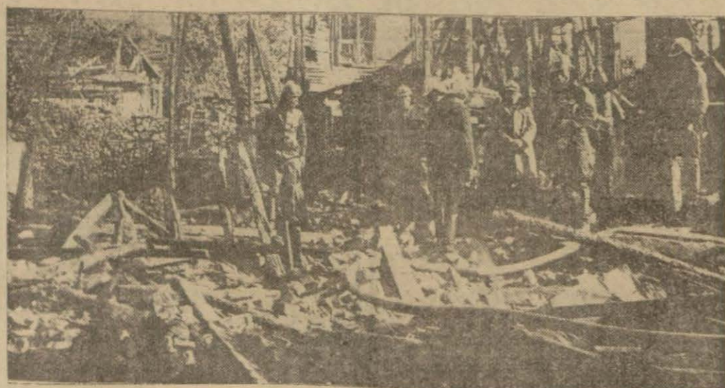
İstanbulda sık sık başgösteren ganginlerden perişan bir görünüş
